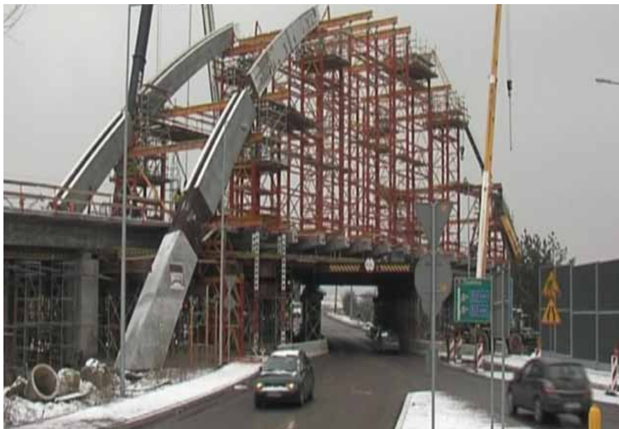
W ramach obwodnicy północno-wschodniej powstanie m.in. wiadukt nad ul. Trzebińską fol. Łukasz Michalik
